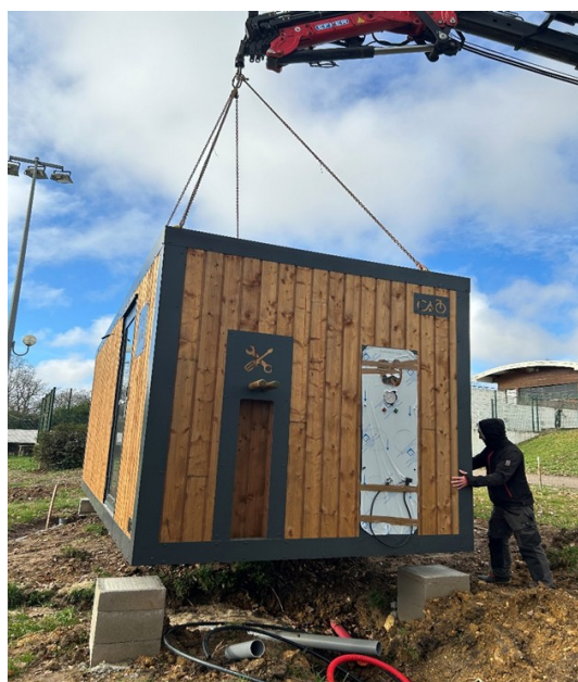
Installation du module Cyclocamp (cuisine et local vélo)
